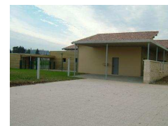
Le Pôle intercommunal pour la petite enfance Crédit photo : CCCLB
