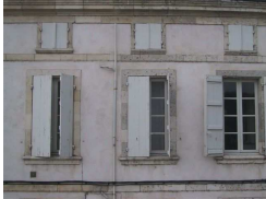
Façade en centre-bourg Crédit photo : Pact Habitat et Développement 47
